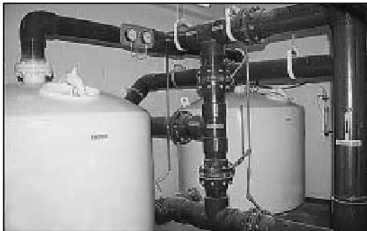
شکل (۵-۳) سیستم صافی شنی
